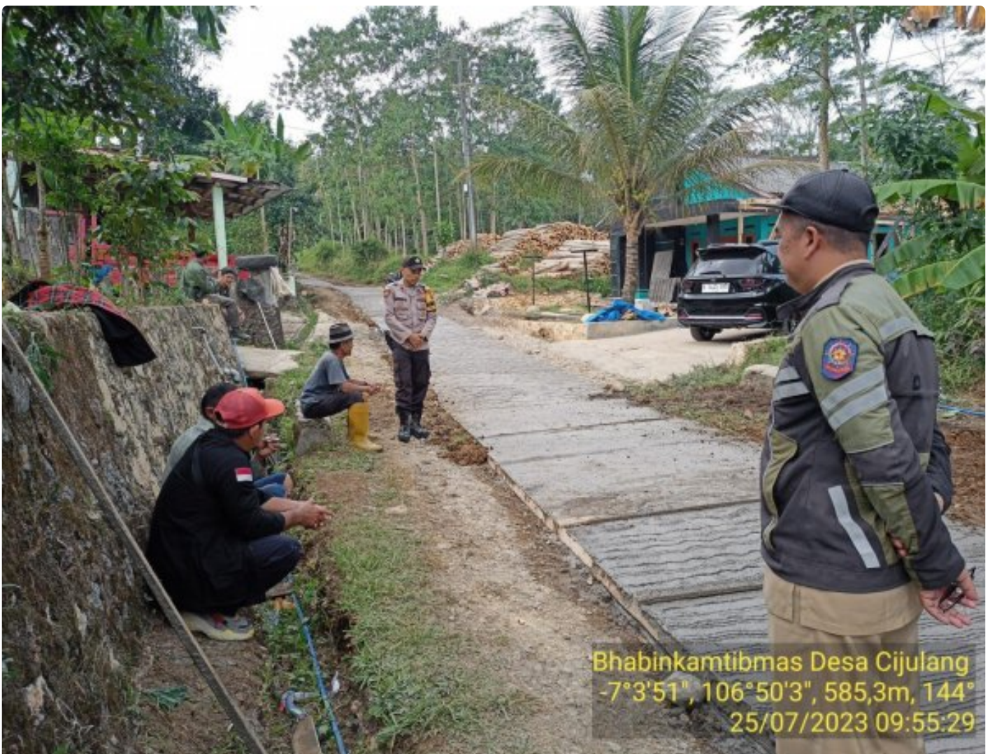
Aipda Sudiro Monitoring Pembangunan MCK di Desa
