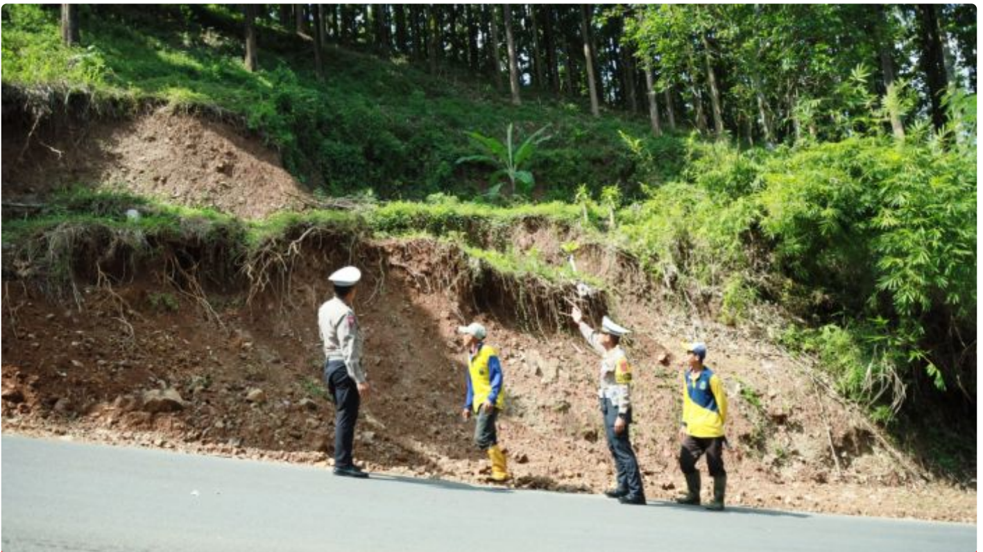
Survei Tanah Longsor di Cikidang Sukabumi, Akp Fiekry Himbau agar Pengendara selalu Waspada
